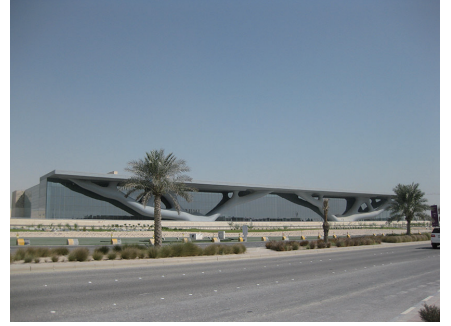
カタール国立コンベンションセンター
